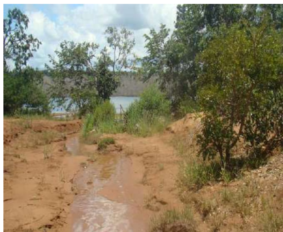
Foto - 9. Vista parcial da área do processo erosivo PE3 próximo a chegada ao reservatório.
