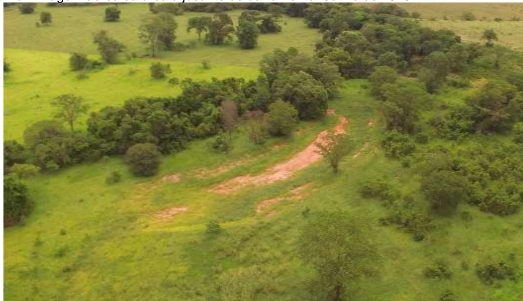
Figura 16 - Imagem aérea da área à jusante do barramento. Junho de 2020.
