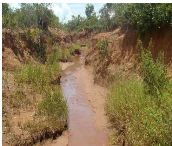
Foto - 8. Vista geral interna do processo erosivo PE3 já atingindo o lençol freático.
