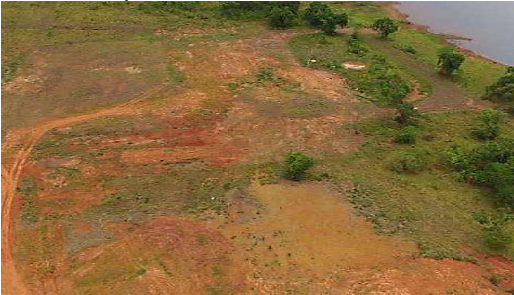
Figura 3 – Imagem aérea das áreas anteriormente ocupadas por: Central de Concreto, Laboratório de Concreto e Solo e Pré-montagem, totalmente desmobilizada. Janeiro de 2020.
