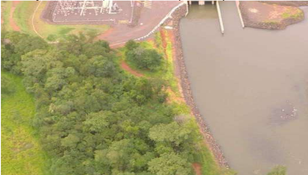
Figura 12 – Imagem aérea da área próxima à casa de força e subestação. Junho de 2020.
