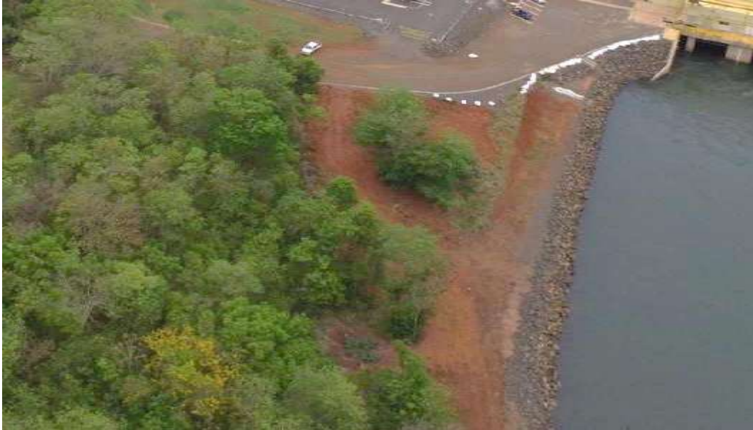
Figura 11 – Imagem aérea da área próxima à casa de força e subestação. Janeiro de 2020.
