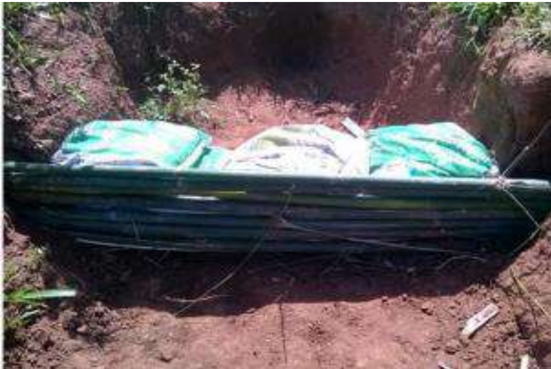
Figura 5 – Exemplo de utilização de paliçada de bambu com sacos de rafia contendo terra.
